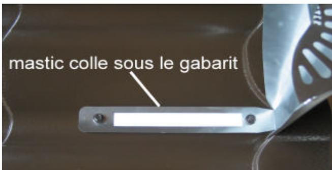
Positionner la châtière en butée contre la marche de la tuile et fixer le gabarit avec deux vis.
